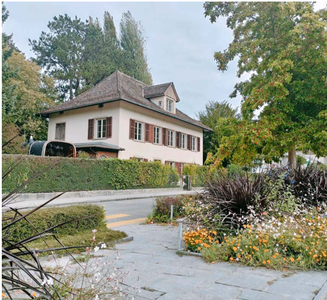
Die ehemalige Direktorenvilla auf dem Gaswerkareal soll umgebaut werden: Der Verein Lindlisauna plant eine Saunalandschaft im und um das Gebäude.
